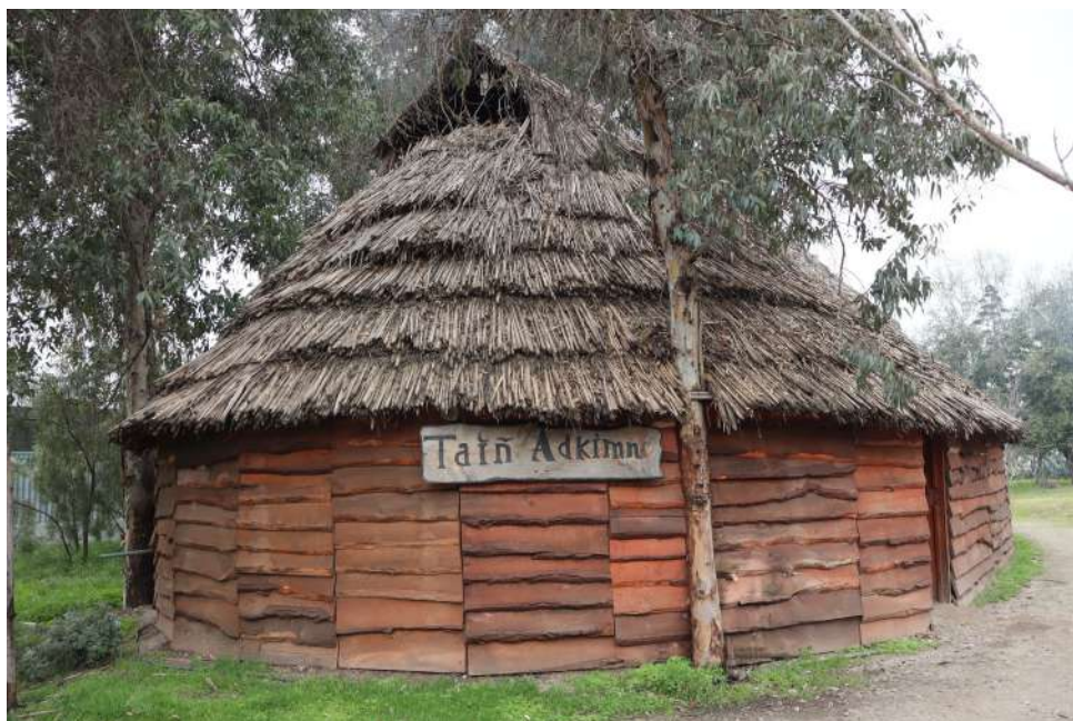
Figura 4.1: La ruka dell'associazione Taiñ Adkimn costruita all'interno del centro cerimoniale Kintu Rayen.
